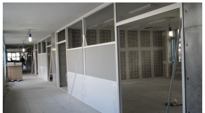
新校舎東棟の廊下
