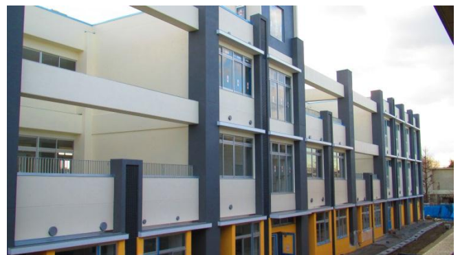
体育館側から見た新校舎東棟
