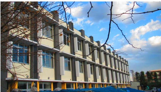
校庭側から見た新校舎東棟
