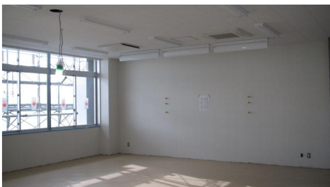
新校舎東棟の教室
